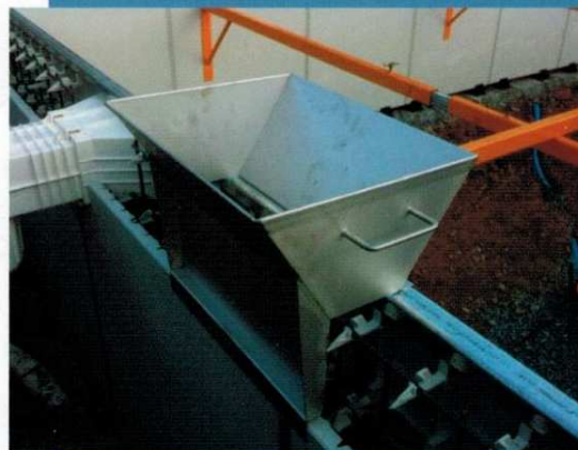
Exemple de goutte pour coulage.
